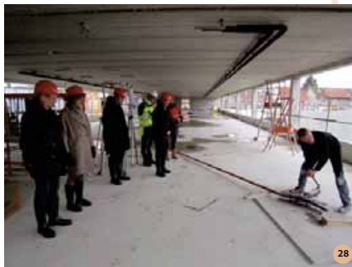
Le chantier en février 2016
