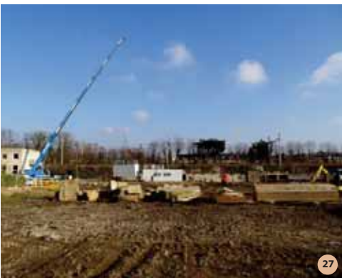
Le chantier en février 2015
